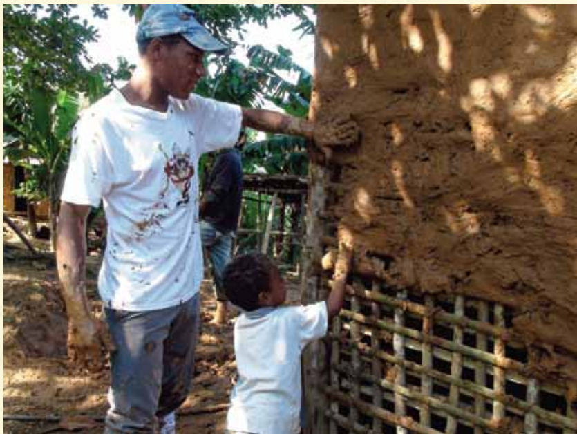
Cozinha de pau a pique sendo construída no Quilombo de Iva- porunduva. Foto: Douglas Mansur
