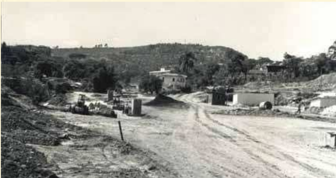
Trecho em obras da Av. Silva Lobo. Acervo SUDECAP Aproximadamente 1970.
