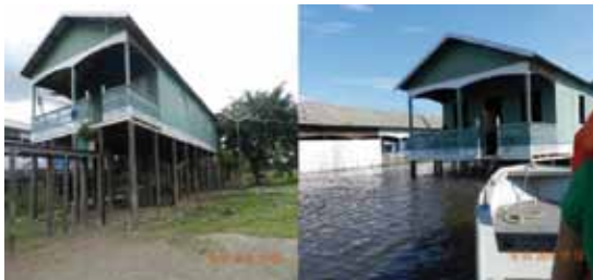
Residência do tipo palafita, do casal Erinaldo e Dileusa, na comunidade, nos períodos de vazante e de cheia.
